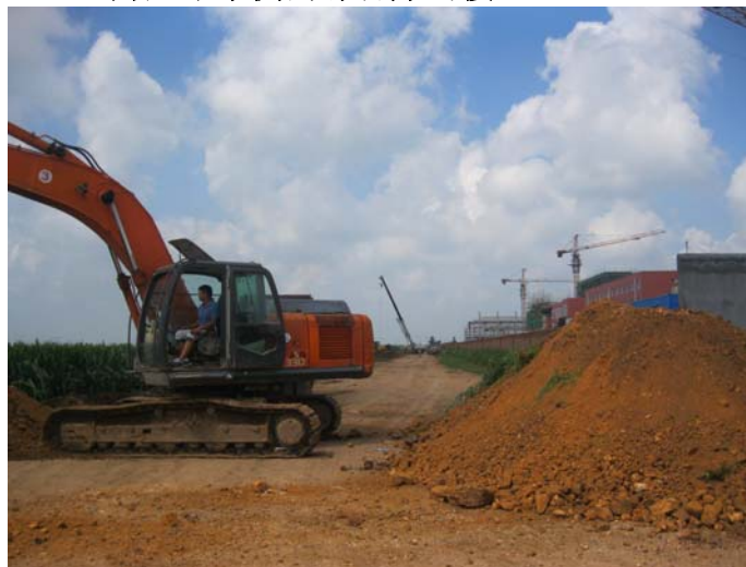
升压站（围墙）南侧的在建市政道路
