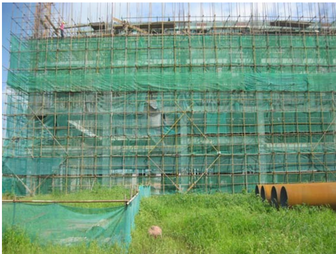
升压站现状及北侧的在建汽机间
