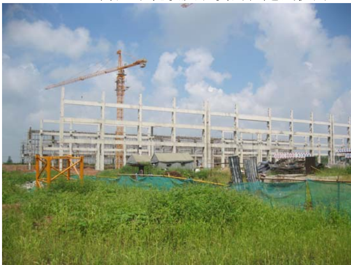
升压站西侧的在建料场
